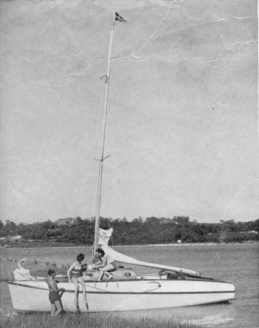
Les quilles ayant été escamotées, Atalanta peut flotter dans moins de 50 cm. d'eau. Mit eingezogenen Kielen lässt sich die 'Atalanta' in weniger als 50 cm. Wasser flott halten. With keels retracted Atalanta will float in less than 2 feet of water.
